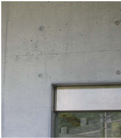
図表 平常時から表面のひび割れ
