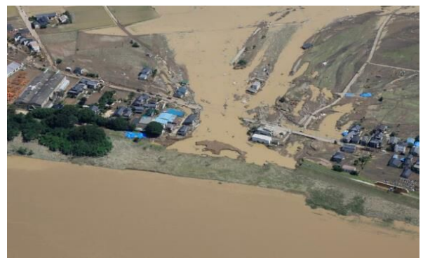
堤防決壊による家屋の流失(鬼怒川)
