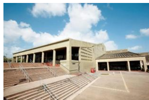
名称 ：沖縄市民会館 機能 ：大ホール・中ホール ※老朽化のため休館中 ※大規模改修検討中
