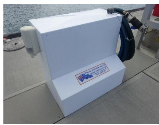
図8 汚水処理ポンプの例
