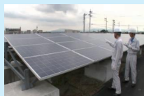
太陽光発電設備の検査の様子
