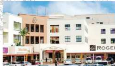
■プラザハウス
