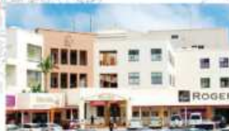
■プラザハウス
