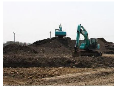
津波堆積物の仮置き事例
