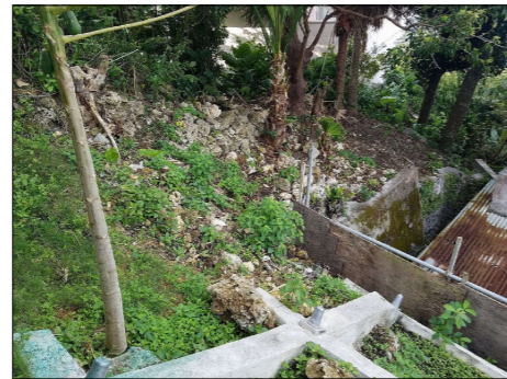
写-1：既設ロックボルト工の境界付近にて、不安定な石灰岩礫群が存在。仮囲いしているが、効果が無い。
