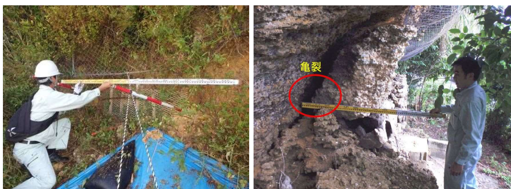
写真 4-3-1-2. 平成 28 年度・墳墓調査状況
