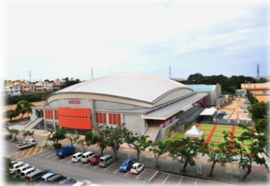
建て替えられた体育館
