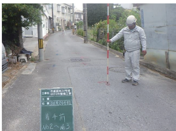
写真：市道中越来24号線(施工前)
