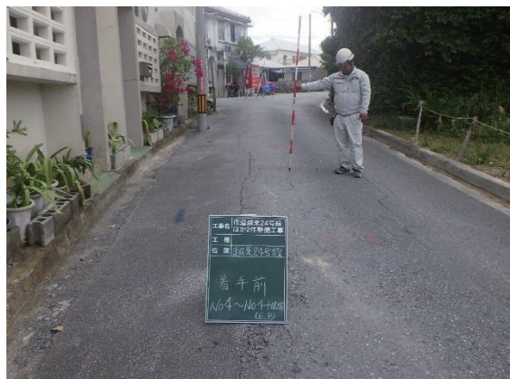
写真：市道中越来24号線(施工前)
