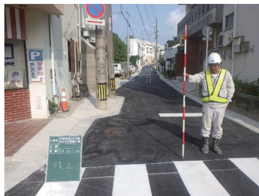
写真：市道中越来24号線(施工後)
