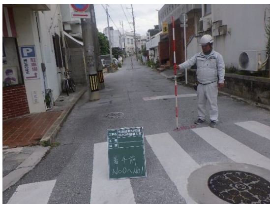
写真：市道中越来24号線(施工前)
