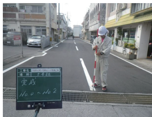
写真：市道中の町5号線(施工後)
