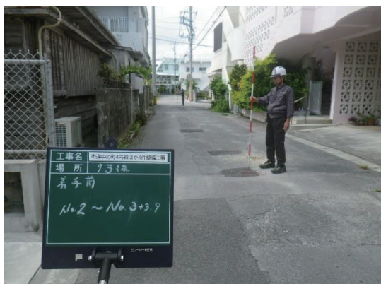
写真：市道中の町3号線(施工前)
