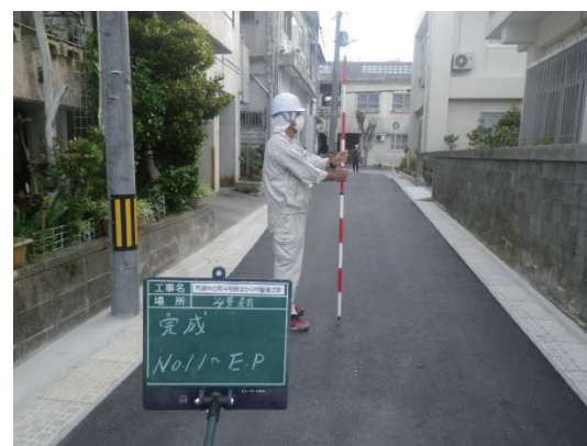
写真：市道中の町4号線(施工後)
