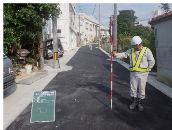
写真：市道中越来24号線(施工後)
