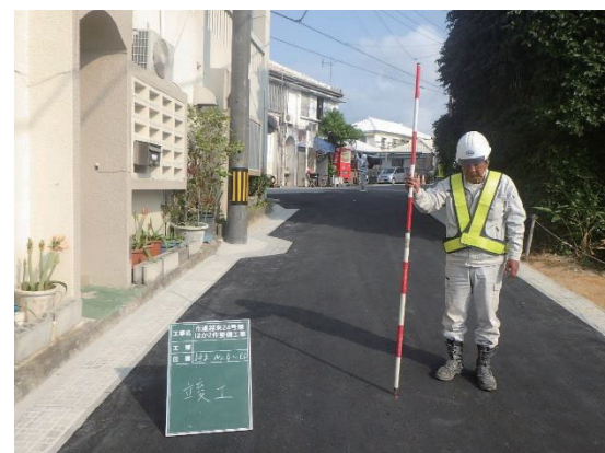
写真：市道中越来24号線(施工後)
