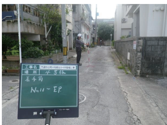
写真：市道中の町4号線(施工前)
