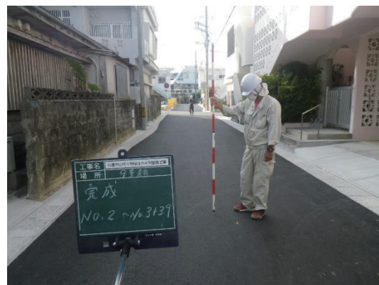
写真：市道中の町3号線(施工後)
