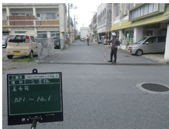
写真：市道中の町5号線(施工前)
