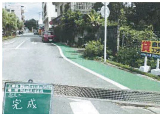
写真：市道越来八重島線(施工後)
