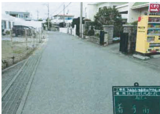
写真：市道美里高校北側線(施工前)
