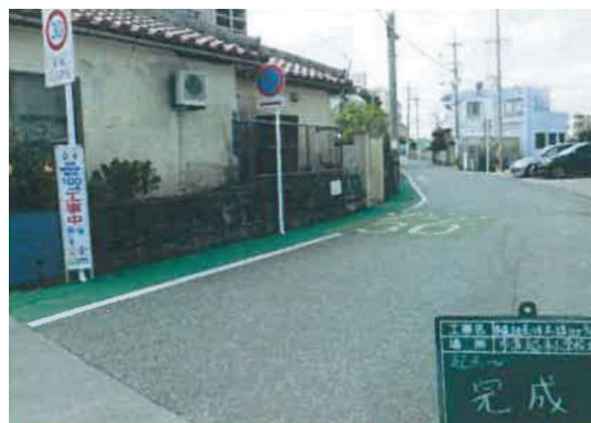
写真：市道越来小学校北側線(施工後)
