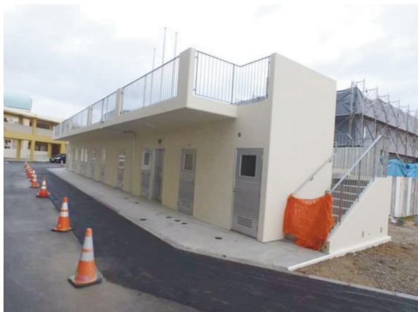
写真：部室倉庫・屋外便所
