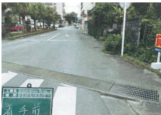
写真：市道越来八重島線(施工前)
