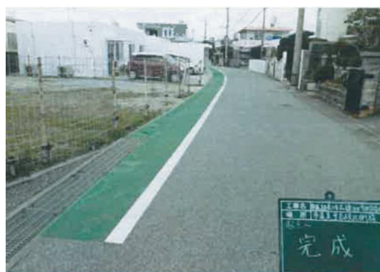
写真：市道美里高校北側線(施工後)
