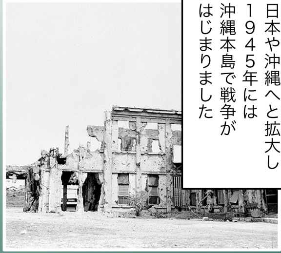
破壊された校舎
