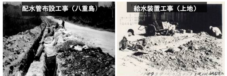
当時の水道工事の様子(1959年)
