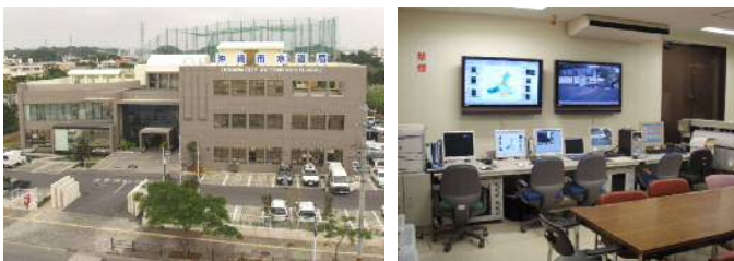
新庁舎外観と計装監視室
