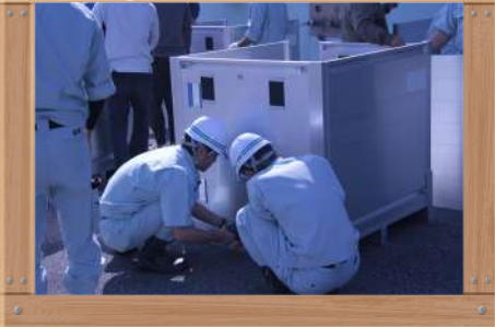
①給水コンテナ組み立て
