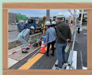
市内工事現場 (美東小学校線)
