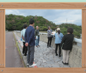
漢那ダム(堤体)
