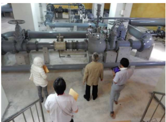
▲胡屋配水池内部配管状況視察
