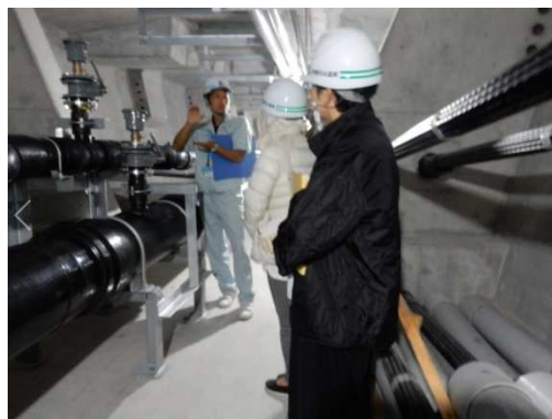
▲橋梁内部、管渠設置状況
