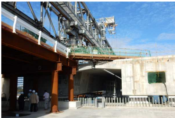
▲東部海浜埋立地区橋梁箇所
