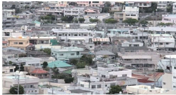
多くの住宅屋上に貯水槽が見受けられる
