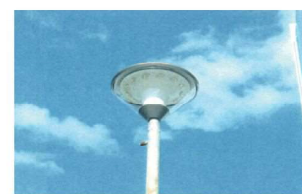
平成26年10月～12月配水池・ポンプ場の外灯工事(LEDへ取替)
