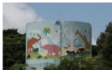
胡屋配水池築造
