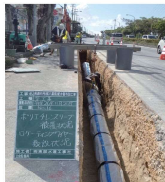
平成26年11月配水管布設工事 (GX形ダクトイル鋳鉄管：耐震管)
