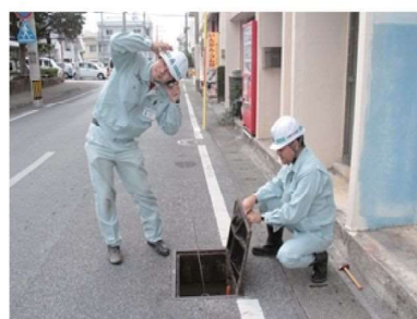
漏水調査業務の様子
