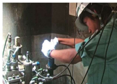
減圧弁のメンテナンス及び水圧調整作業
