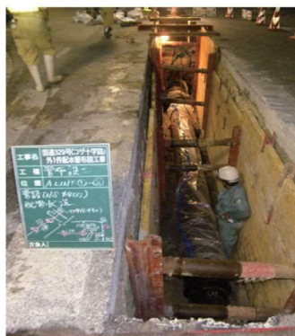
平成25年9月配水管布設工事 (NS形ダクトイル鋳鉄管：耐震管)
