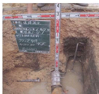
指定工事業者による配水管漏水修繕工事
