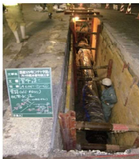
平成25年9月配水管布設工事 (N S形ダクタイル鋳鉄管:耐震管)
