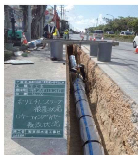
平成26年11月配水管布設工事 (G X形ダクタイル鋳鉄管:耐震管)
