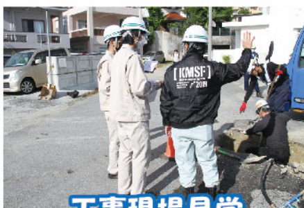
工事現場見学
