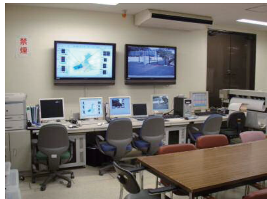
新庁舎外観と計装監視室
