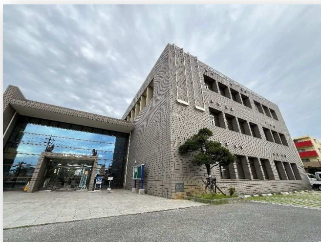
沖縄市上下水道局庁舎
