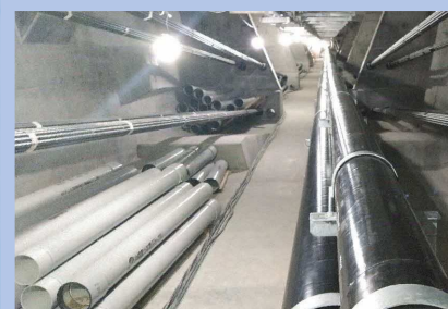
県道 20 号線橋梁内水道管設置
