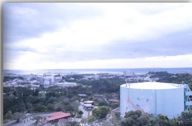
胡屋配水池付近の高台から望む東海岸
