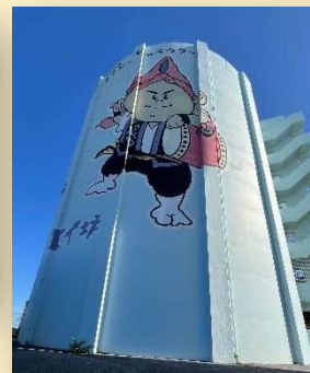
八重島第2配水池
