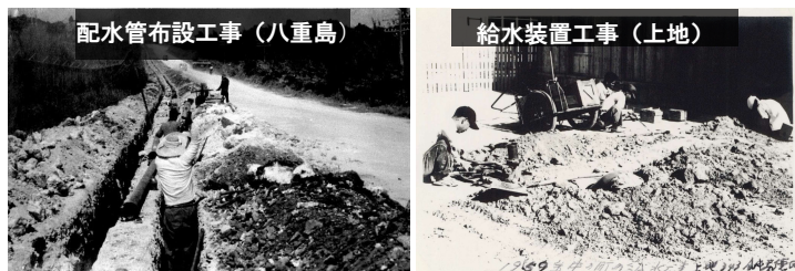
当時の水道工事の様子(1959年)
