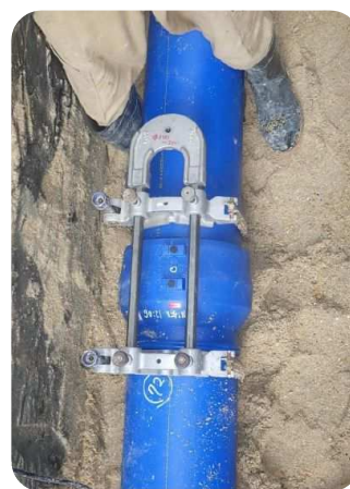
ポリエチレン管の融着 (2024 年 5 月 泡瀬地内)
