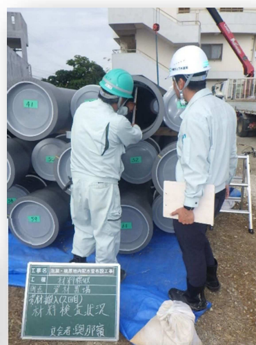
水道耐震管検査の様子
