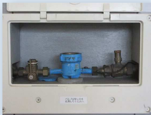
水道メーター逆流防止機能付止水栓の採用
