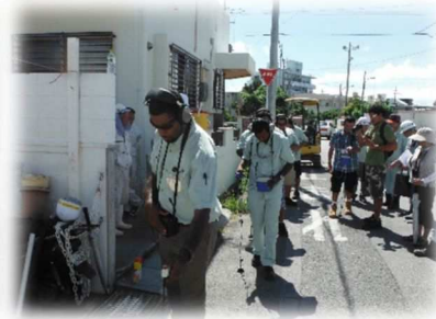
▲漏水調査研修の様子
