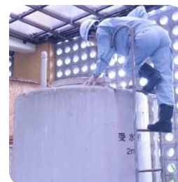
▲職員による貯水槽タンクの確認
