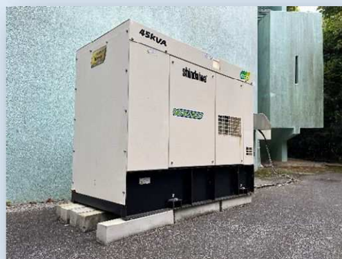
水道施設への非常発電機設備の設置
