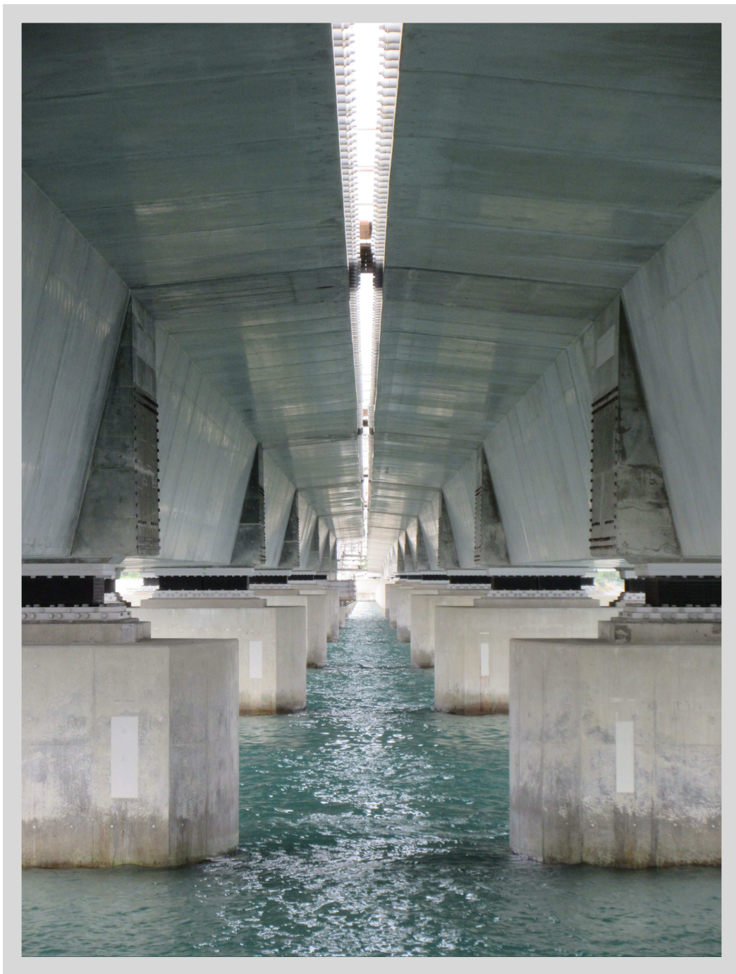
東部海浜埋立地に延びる県道 20 号線橋梁の橋台 (2024 年 12 月撮影)
