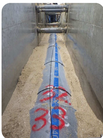
ダクタイル鋳鉄管の布設 (2024 年 12 月 桃原地内)
