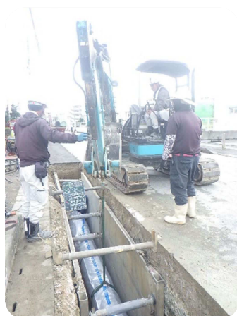
水道耐震管布設状況 (2024 年 12 月 桃原地内)
