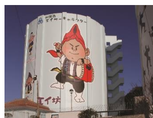
八重島第2配水池
