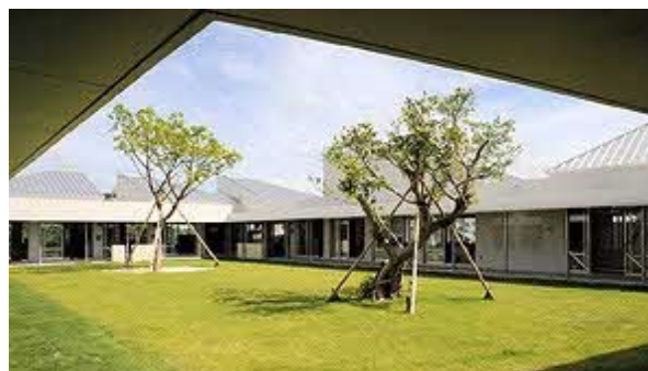
鉄筋コンクリート平家建
