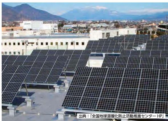
工場屋上の太陽光発電パネルの設置例
