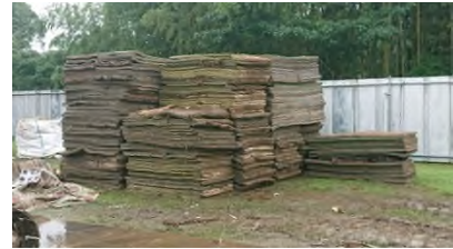
水分を含んだ畳の仮置き事例
