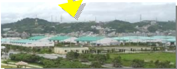
レンタル工場用地は工場が立ち並び活気ある稼働の状況がうかがえる。
